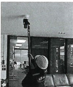
รูปที่ 15 การทดสอบ Smoke, Heat Detector ที่ Administration Building
