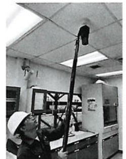
รูปที่ 10 การทดสอบ Smoke Detector ที่ Water Treatment Plant
