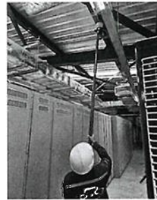
รูปที่ 5 การทดสอบ Smoke Detector ชั้น 1 อาคาร Electrical Building
