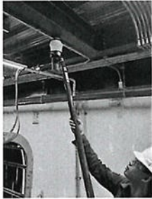
รูปที่ 4 การทดสอบ Smoke Detector ชั้น Ground อาคาร Electrical Building
