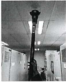
รูปที่ 3 การทดสอบ Smoke Detector และ MANUAL CALL POINT ชั้น 2 ห้อง Control Building
