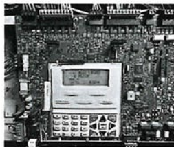
รูปที่ 11 หน้าจอแสดงผลของระบบ Pre-Action ชั้น 1 อาคาร Workshop
