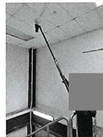
รูปที่ 5 การทดสอบ Smoke Detector ชั้น 1 อาคาร Electrical Building
