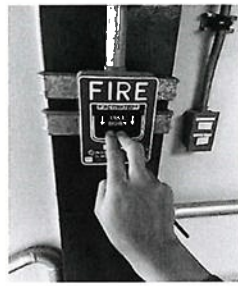
รูปที่ 3 การทดสอบ Smoke Detector และ MANUAL CALL POINT ชั้น 2 ห้อง Control Building
