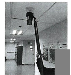
รูปที่ 2 การทดสอบ Smoke Detector ชั้น 1 อาคาร Control Building
