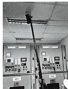
รูปที่ 9 การทดสอบ Smoke Detector ชั้น 1 ห้อง Terminal Substation อาคาร Switchyard
