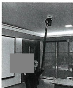
รูปที่ 15 การทดสอบ Smoke, Heat Detector ที่ Administration Building
