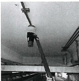
รูปที่ 8 การทดสอบ Smoke Detector ชั้น Ground อาคาร Switchyard
