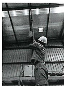
รูปที่ 12 การทดสอบ Smoke Detector ชั้น 2 อาคาร Workshop และ Warehouse
