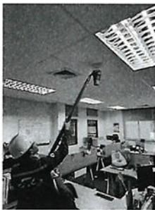
รูปที่ 12 การทดสอบ Smoke Detector ชั้น 2 อาคาร Workshop และ Warehouse
